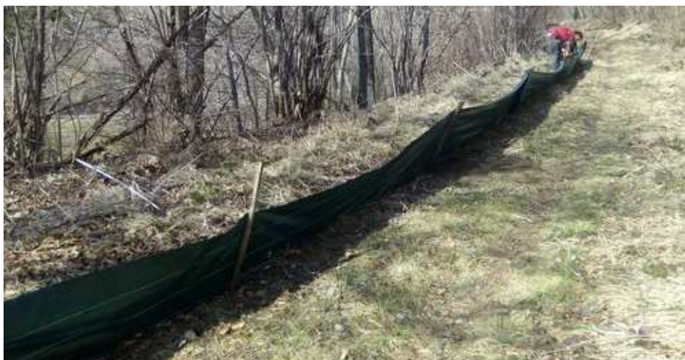
Figure 35 - Exemple de dispositif empêchant l'entrée des reptiles dans la zone de travaux.
